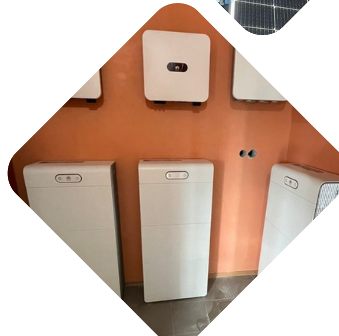
Anlage des Krankenhauses in der Region Dnipro
